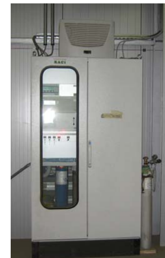
KNAUF INSULATION (TERMO) Škofja Loka, Slovenia Proizvodnja kamene volne, AMS: CO, CO 2 , O 2 , prah, O 2 (In-situ) ČISTILNA NAPRAVA ODPADNIH PLINOV KUPOLNE PEČI
